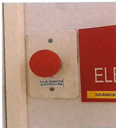
Fig. 4) sgancio elettrico (console RM)
