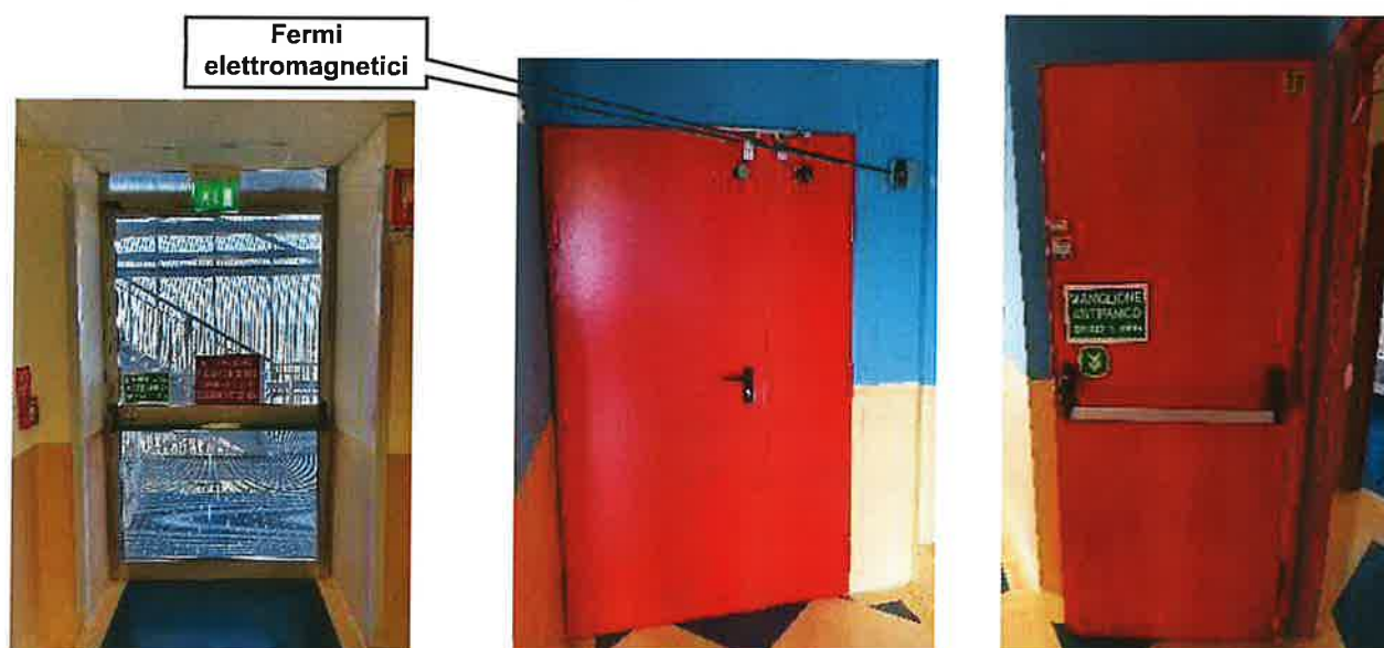
Vista di alcune uscite e porte di sicurezza
