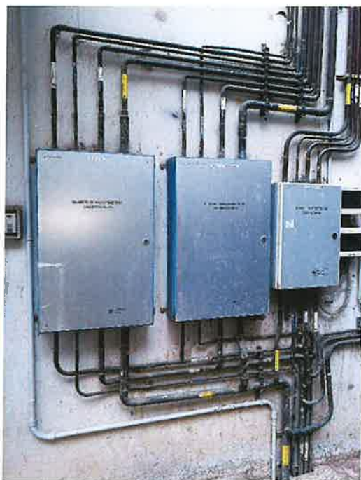
Valvole di sezionamento esterne gas medicali posizionate al piano terreno
