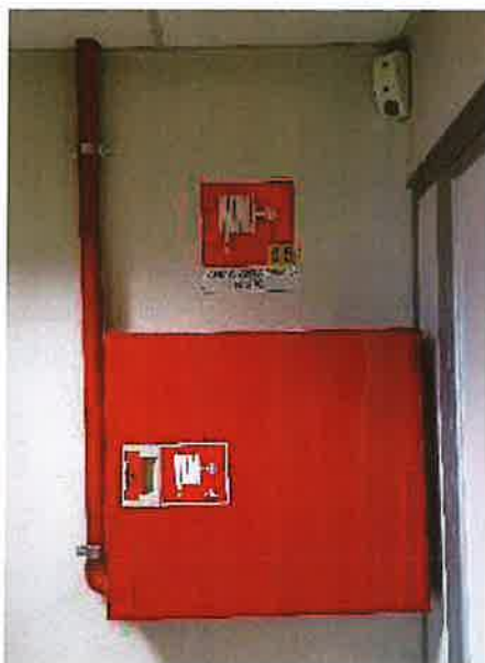
Vista di alcuni idranti e naspi installati
