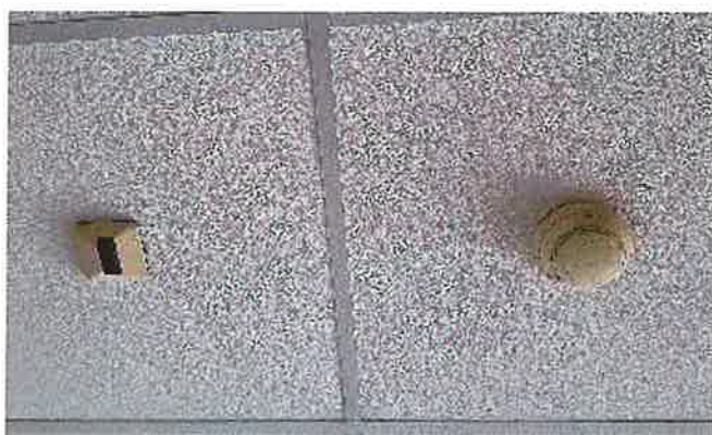
Vista di alcuni rilevatori di fumo ambiente e segnalatori installati
