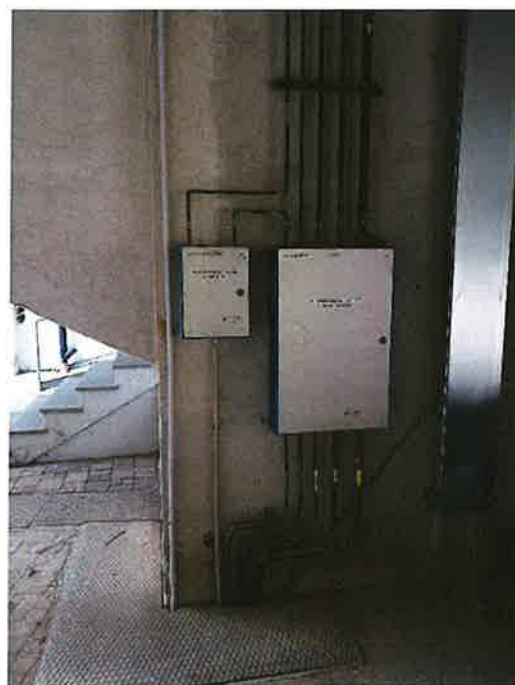
Valvole di sezionamento esterne gas medicali posizionate al piano terreno
